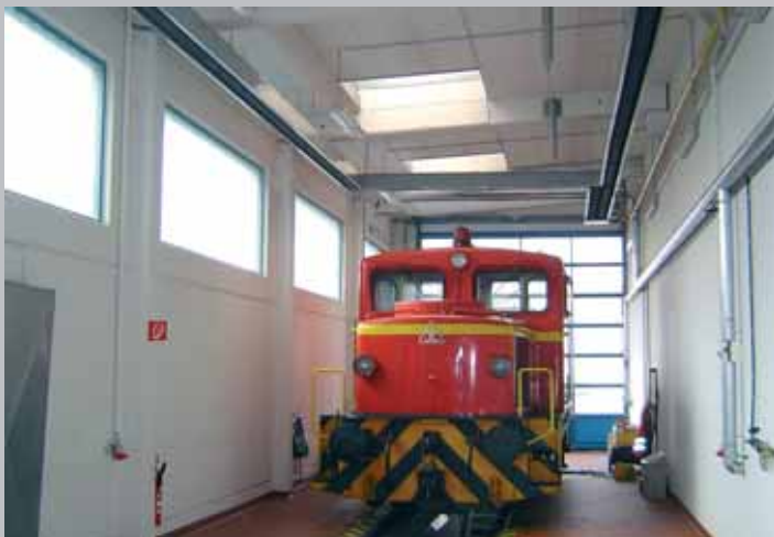
Lok-Instandsetzungshalle Bauform „O“
