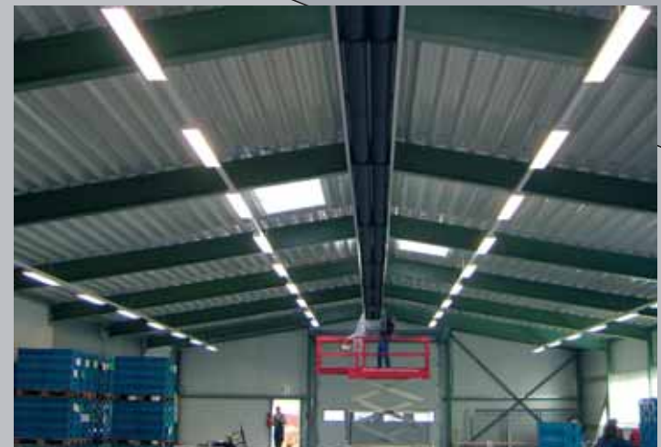
Kommissionshalle Bauform „l“
