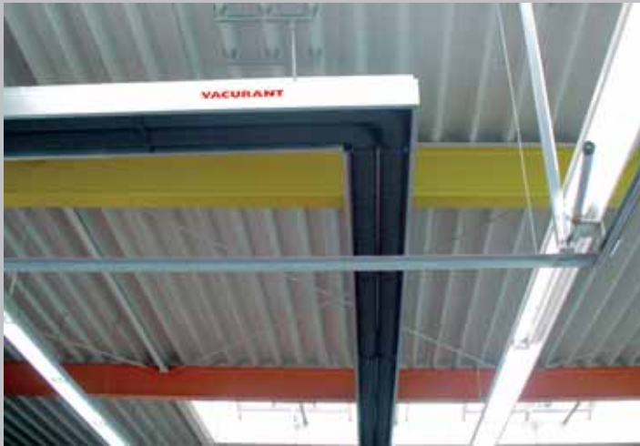
Produktionshalle Bauform „L“
